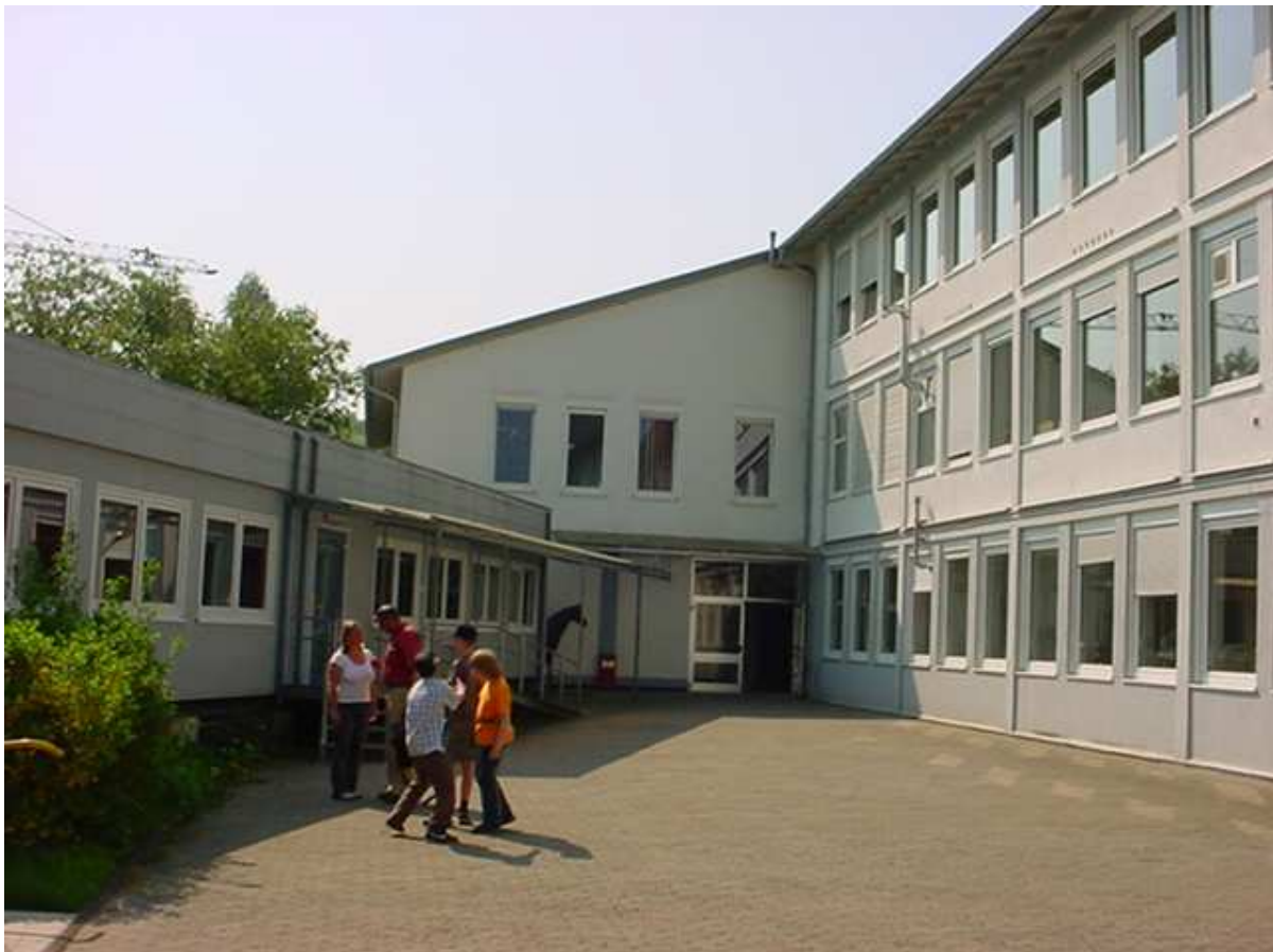
Bild 2.1: Der Innenhof der Carl-Strehl -Schule
